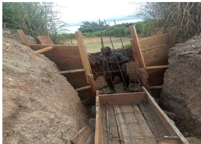
Bau des Schleusentors am großen Staubecken
